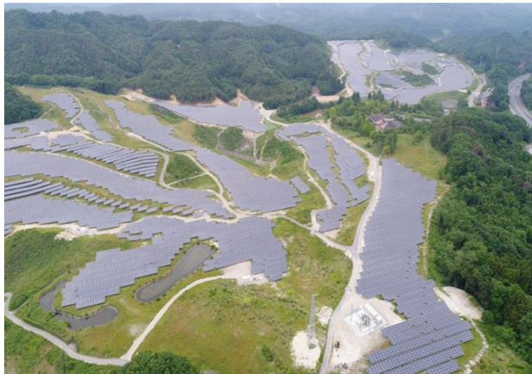
【太陽光発電所敷地】
