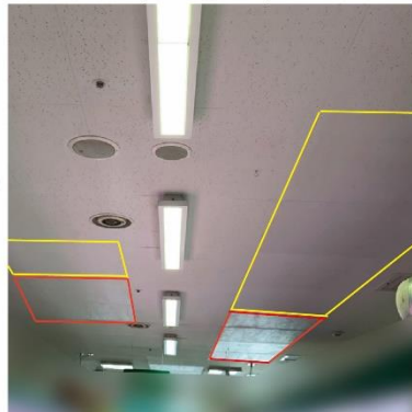
▲経過観察状況(黄枠内:カビテクト基材(未塗装)/赤枠内:カビテクト)
