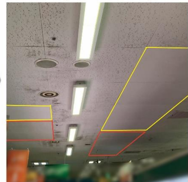
▲経過観察状況(黄枠内:カビテクト基材(未塗装)/赤枠内:カビテクト)
