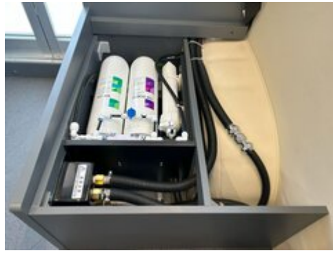
逆浸透膜を使った浄水フィルター
