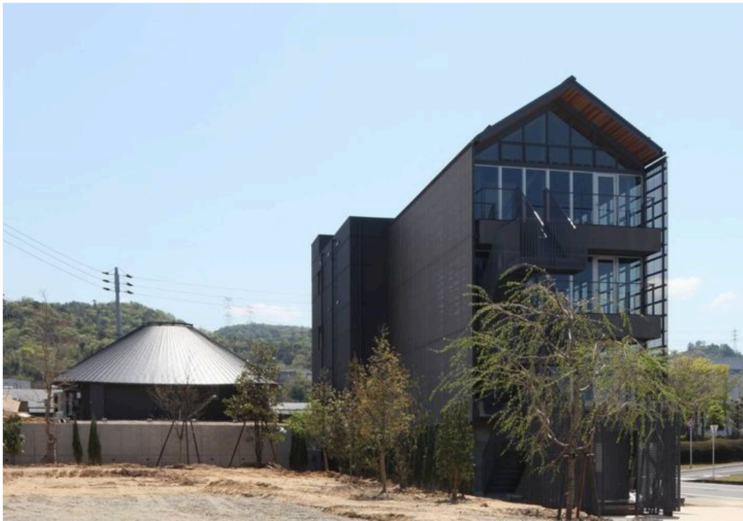
左：つたのは保育園外観 右：一般向けカフェ・子育て支援室、社内福利厚生施設他予定（丸和新社屋内）
